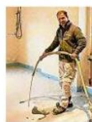
Dank vieler Arbeitsstunden von Mitgliedern der Zunft ist die Sanierung des 200 Quadratmeter großen „Geißenstalls“ gelungen.
